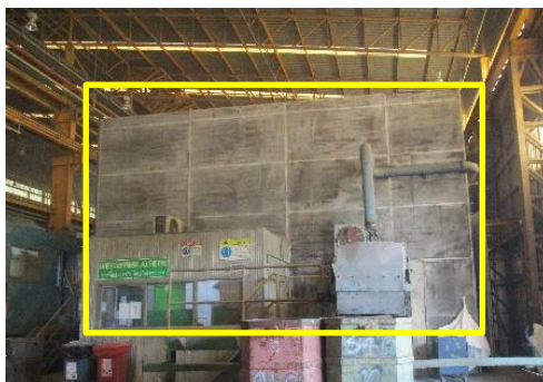
ภาพที่ 2-7 ห้องครอบเสียง/การติดตั้งวัสดุดูดซับ
