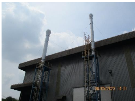
ภาพที่ 2-1 ระบบดักฝุ่นแบบถุงกรอง (Bag House)
